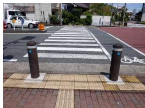
歩道（伊勢磯部線：県-16） 歩行者防護用ボラードが視覚障がい者誘導 用ブロックに食い込んで設置されている。
