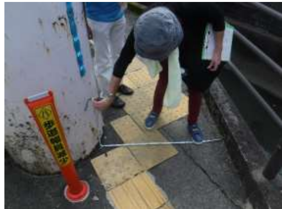
歩道の幅員の確認
